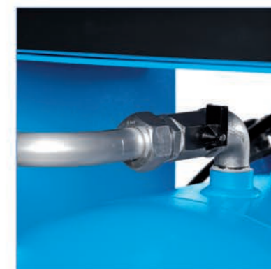
rugalmas csatlakozás a kerülő (bypass) hűtveszárítóhoz
